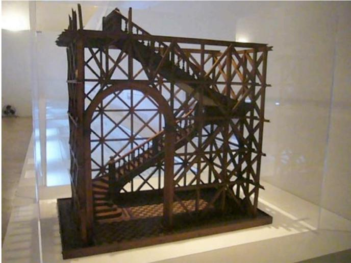
La cage de Pombal, exemple de maquette en bois des constructions antisismiques testées puis utilisées par Pombal et ses architectes. Photo Galinhola/Wikimedia
