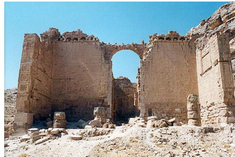
Ce temple de Petra (Jordanie), le Qasr el-Bint, date de la fin du 1<sup>er</sup> siècle et a longtemps résisté, malgré sa taille imposante, aux séismes de la région. Sa construction en briques de terre incluait des lamines de bois, dont le rôle était d'absorber une partie des vibrations sismiques. Il n'a cependant pas résisté au grand séisme de l'an 363. Photo © Angus McIntyre
