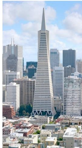
À San Francisco, l'immeuble Transamerica pyramid, construit en 1972 et célèbre par sa forme, possède des fondations et une construction particulières: il est ancré à 15 m dans le sol, avec une structure capable de bouger. La base de l'immeuble est constituée d'un ensemble de poutres de béton en forme de pyramide soutenant l'ensemble (voir photos).
