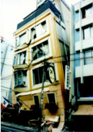
Les conséquences du séisme sur les constructions étaient immédiates: destruction par écoulement. En effet, les va-et-vient du sol cisailaient les fondations des maisons et des immeubles. 721667 bâtiments seront fortement endommagés, dont 181799 complètement détruits par effondrement (ci-contre, un immeuble endommagé par le séisme - [Photo Wikimedia](#)).
